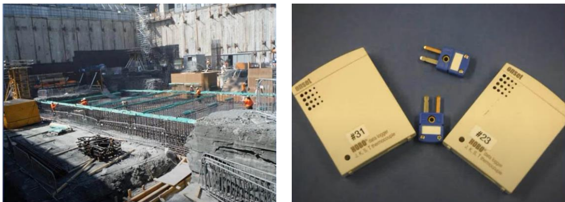
Рисунок 1. One York Street, Канада (справа – регистраторы данных термодатчиков Нобо, слева – этап строительства) [14]
