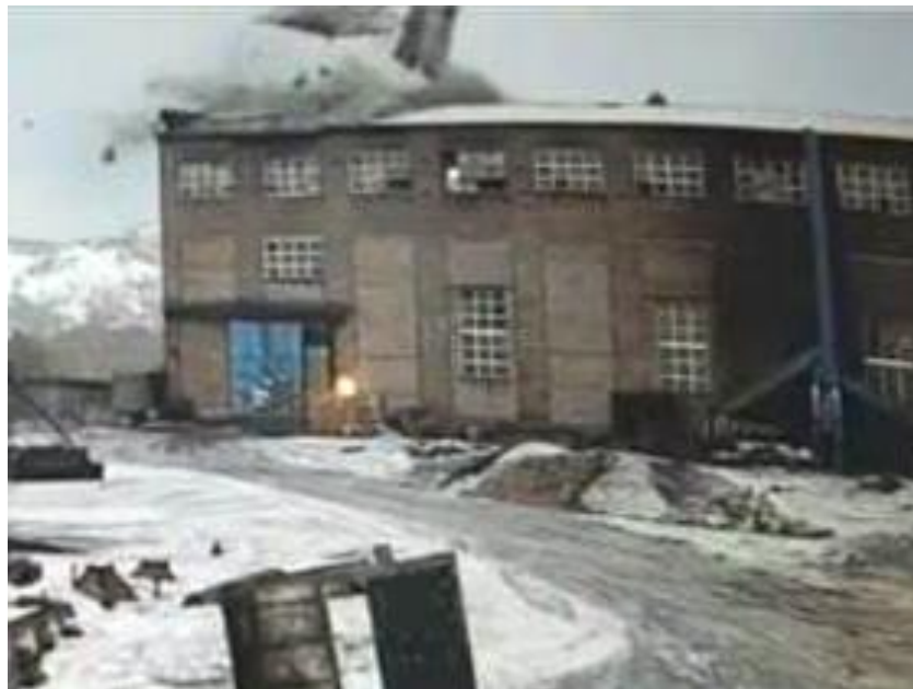
1-сурет. Профильді төсеніштен шатырдың бұзылуының басталуы
