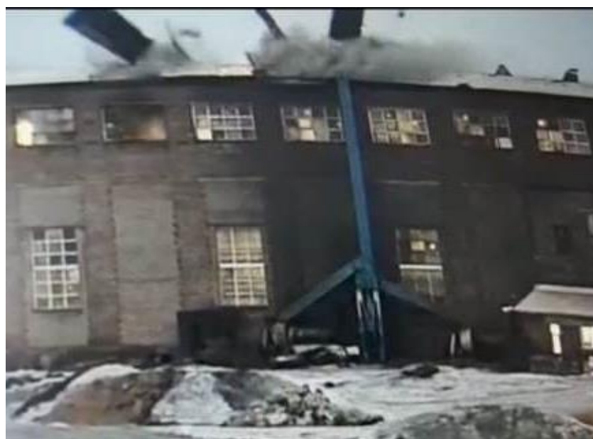
2-сурет. Ішкі ауа қысымының жоғарылауына байланысты шатырдың жарылуы
