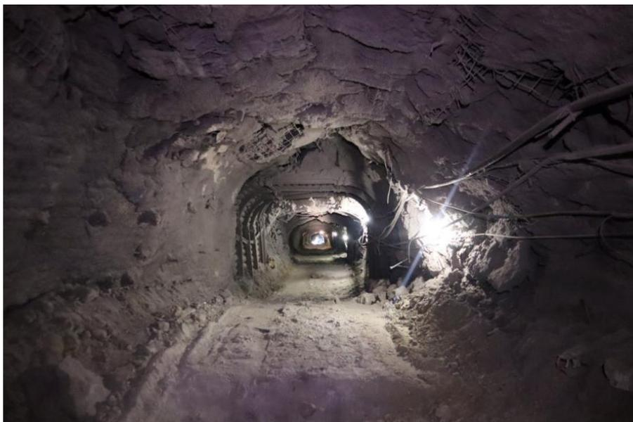
**Рисунок 6.** Деформация поперечного сечения штрека
