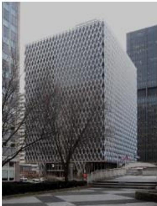
**Рисунок 4.** Здание с фасадом, выполненным в системе «Diagrid»
