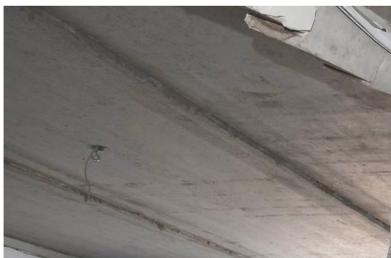
2-сурет. Бес қабатты тұрғын үйге арналған темірбетон материалынан жасалған құрама темірбетон еден плиталары Ескерту – автормен құрастырылған
