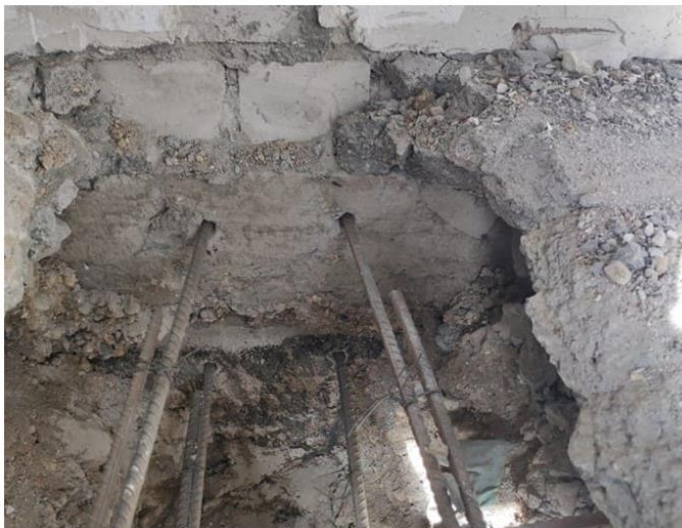
1-сурет. Бес қабатты тұрғын үйдің темірбетон материалынан жасалған сынақ шұңқыры Ескерту – автормен құрастырылған
