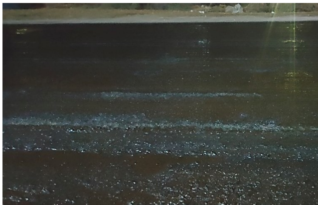
Рисунок 1. Подгрунтовка дорожного покрытия эмульсией ЭБК-2
