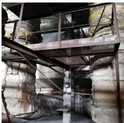
6-сурет. Жинақтық циклонына дейінгі сынама алу нүктесі (БЦ – 250/60+60) – қайта айналу сызығымен
